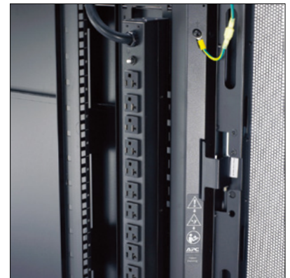
工具無しで取り付けられたラックマウント PDU
